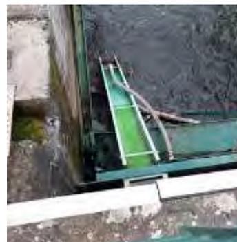
Figure 38 : Passe à civelles du barrage de Boisse, source : Eau-Mega
