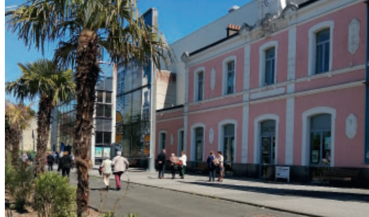
Ancienne gare : façade de l'Espace Culturel
