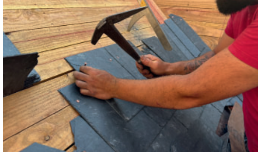
Les travaux de toiture
