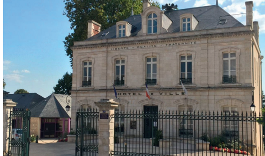
Façade de l'Hôtel de Ville
